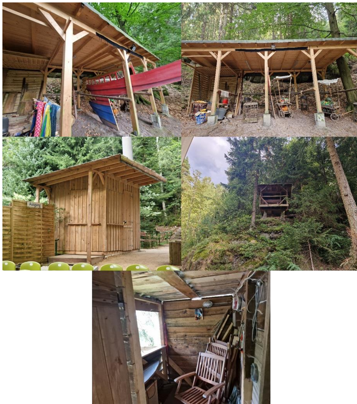
Abb. 16: Unbezeichnete Nebengebäude im Südosten der Fläche
