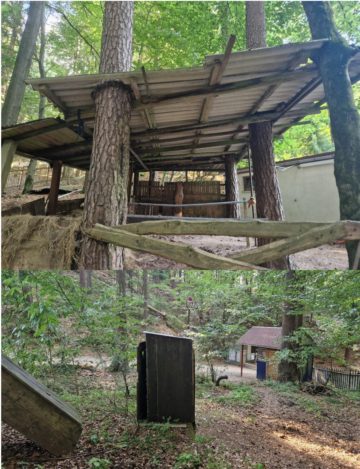
Abb. 7: Pferdeunterstand mit daneben stehendem Toilettenhäuschen
