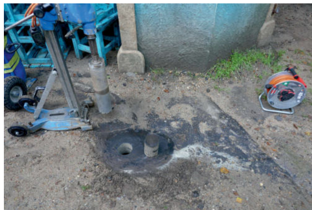
Bild 22: Untersucher Beton mit Teeranstrich der Decke des Orchestergrabens
