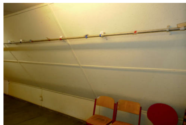
Bilder 47 und 48: Verkleidung der Dachschräge und Decke im OG mit Spanplatten
