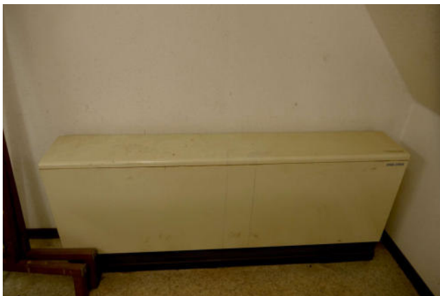
Bild 40: Zu entsorgender Nachtspeicherofen
