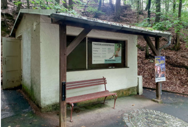
Bild 1: Ansicht des massiven EIt- Gebäudes
