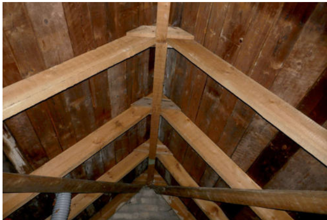
Bild 53: Ansicht Dachaufbau von innen
