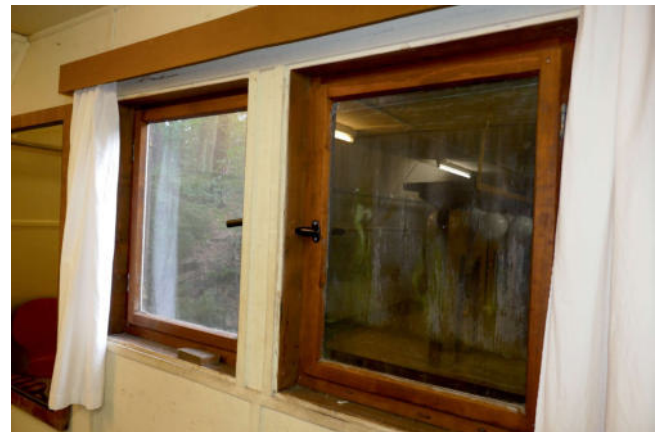
Bild 52: Im vorderen Gebäudeteil zu entsorgende Holz- Fenster
