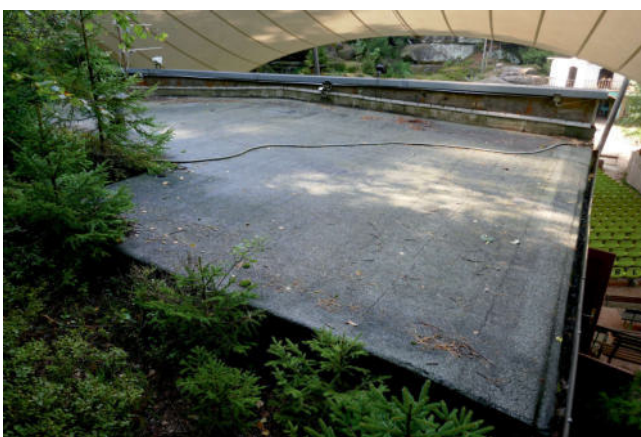
Bild 16: Ansicht Betondach mit Dachpappe
