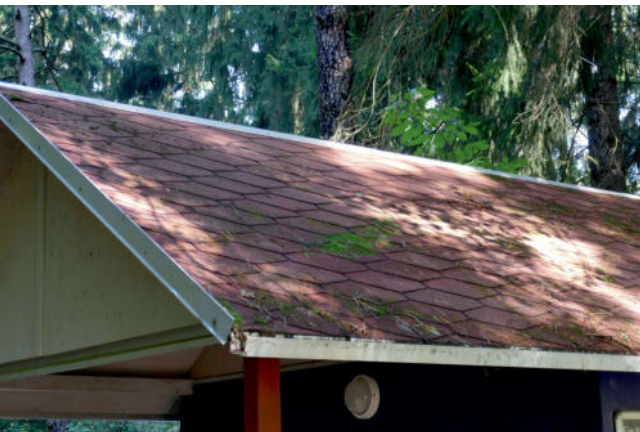
Bild 5: Rote Pappschindeln des Daches vom Kassen- Häusel
