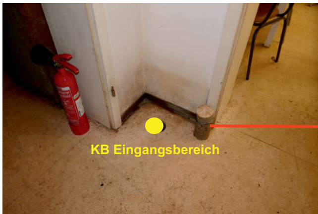
Bilder 31 und 32: Kernbohrung und Bohrkern Betonfußboden Eingangsbereich EG
