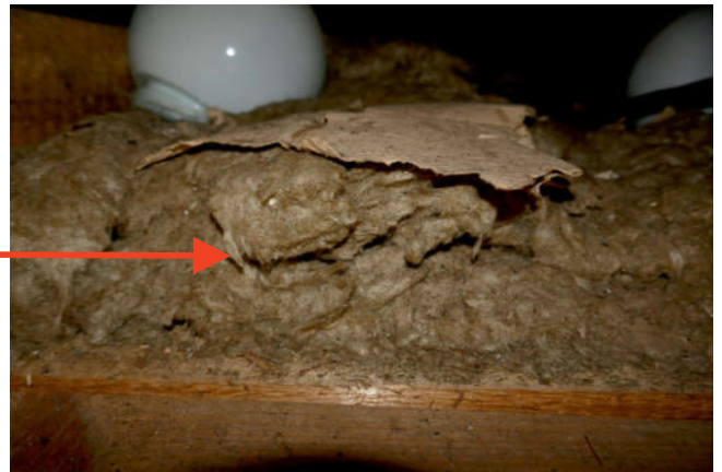
Bilder 49 und 50: Auf Unterhangdecke vorhandene graue Mineralwolle
