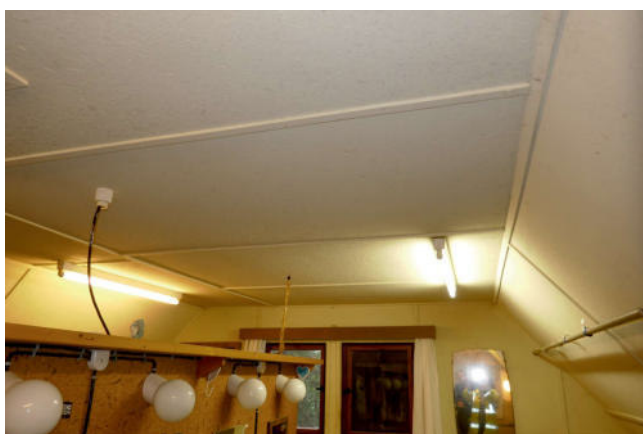
Bilder 47 und 48: Verkleidung der Dachschräge und Decke im OG mit Spanplatten
