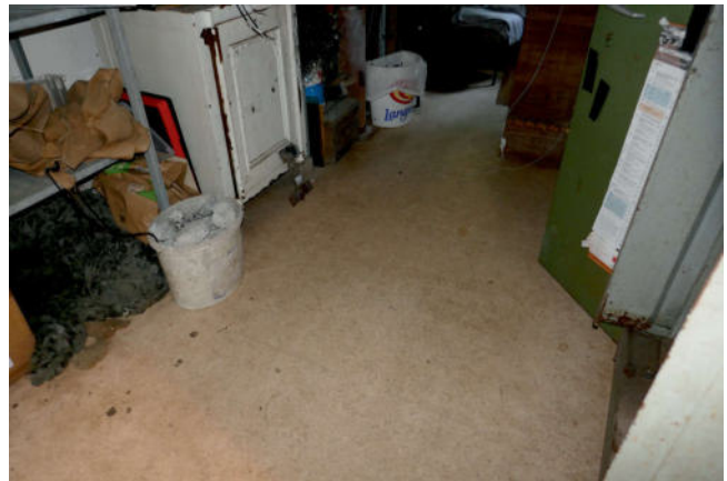
Bild 30: Beispiel Betonfußboden mit PVC- Belag EG
