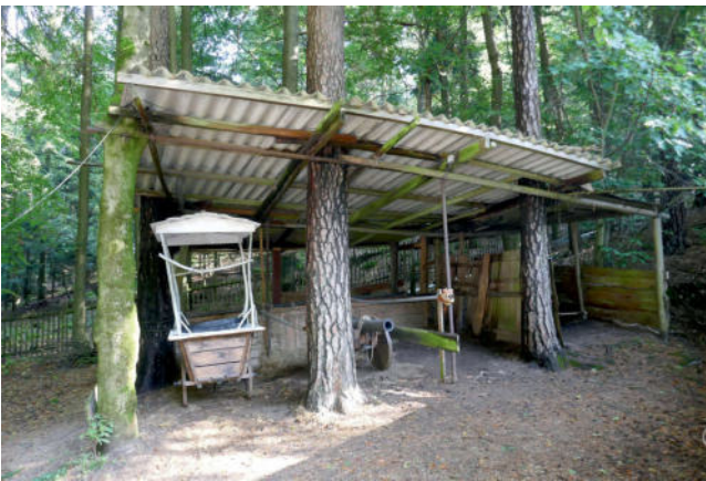
Bild 8: Ansicht Überdachung mit Wellasbest- Dach
