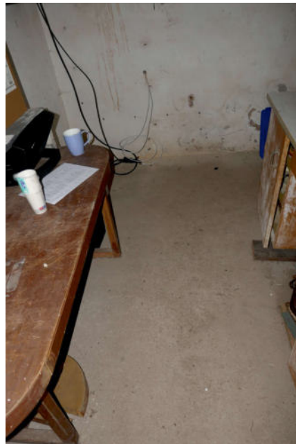
Bilder 13 bis 15: Betonfußböden in allen Räumen
