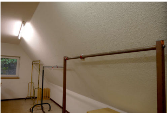
Bild 37: Verkleidung der Dachschräge und Decke im OG mit Gipskartonplatten
