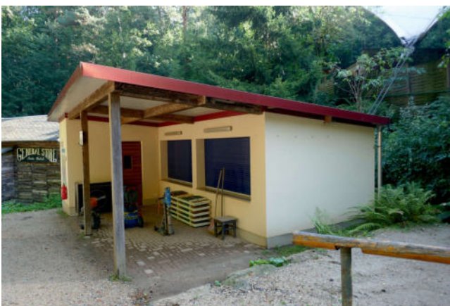
Bild 9: Ansicht Imbiss- Gebäude
