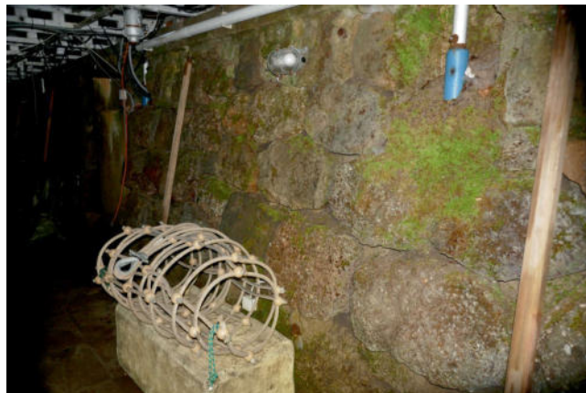
Bild 21: Untersuchtes Naturstein- Mauerwerk
