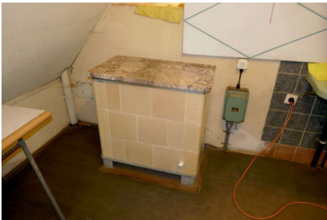
Bild 51: Als gefährlicher Abfall zu entsorgender alter Nachtspeicherofen
